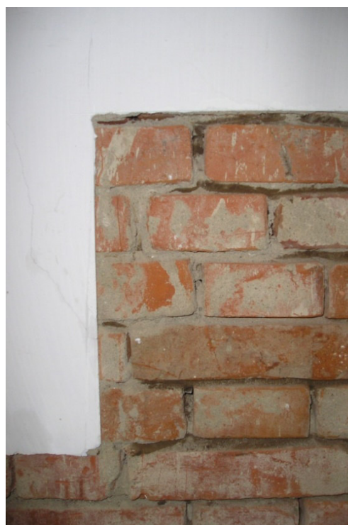
Cihlové zdivo domu
