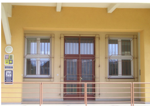
Vstupní dveře do budovy depozitáře
