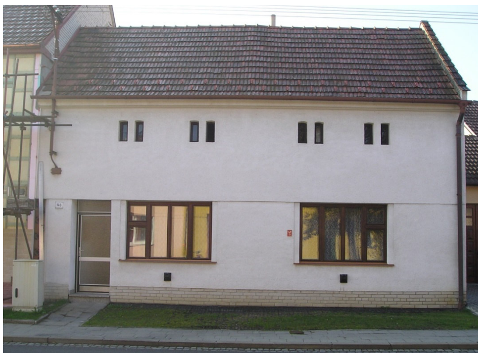
Fasáda domu č.p. 148
