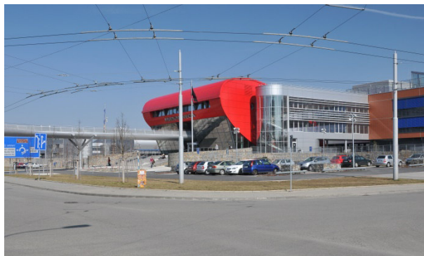
Obr. 7 Pohled z JZ na hlavní vstup UKB
