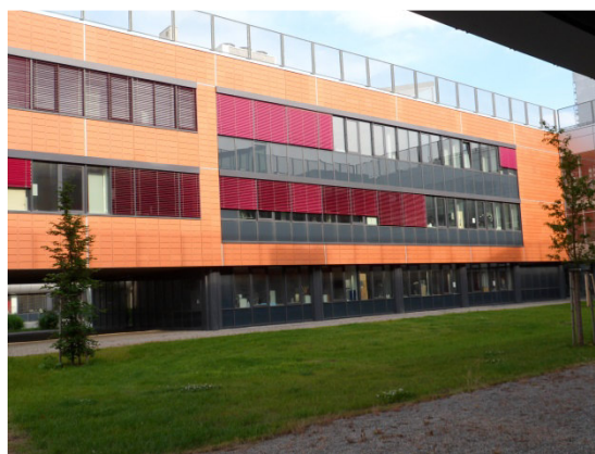
Obr. 20 Pavilon A12, Z fasáda, okna lab.
