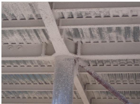
Obr. 15 Protipožární nástřík ocelové kce
