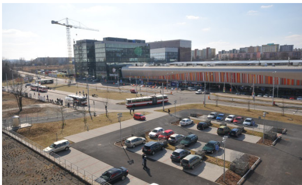
Obr. 8 Parkoviště na Z při vstupu do areálu
