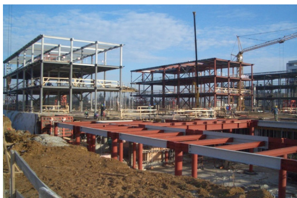
Obr. 17 Nosná ocelová konstrukce
