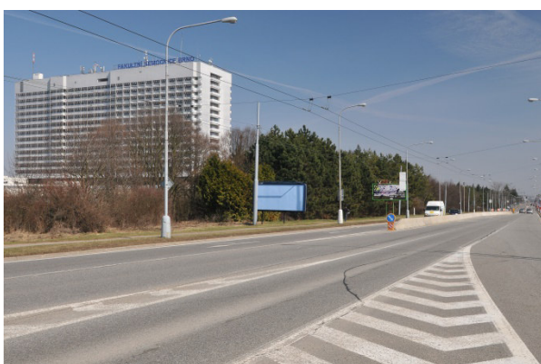
Obr. 12 Silnice R23 jižně od UKB
